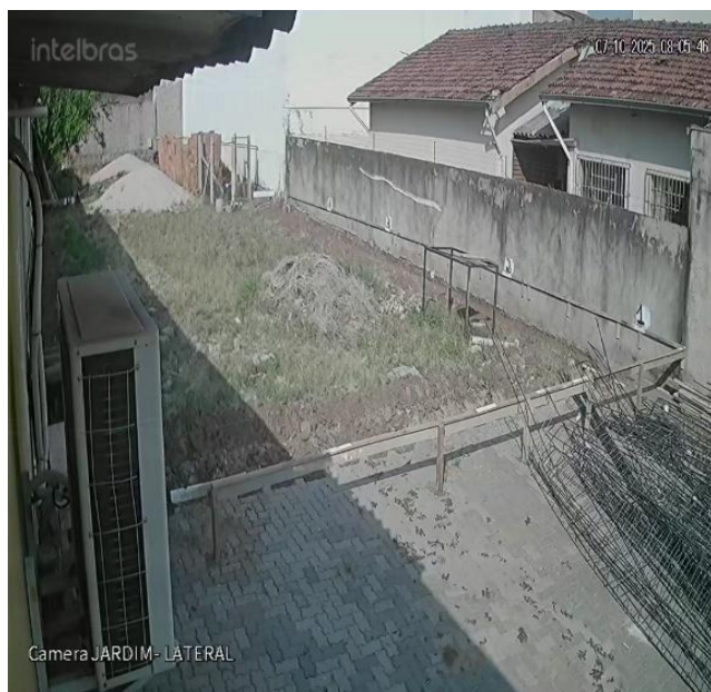
Imagem do terreno ao lado, preparação do local
