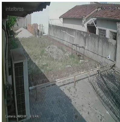
Imagem do terreno ao lado, preparação do local
